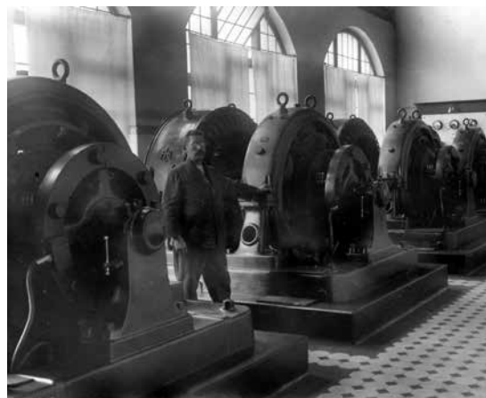
Umformer in der Energie-Leitzentrale
