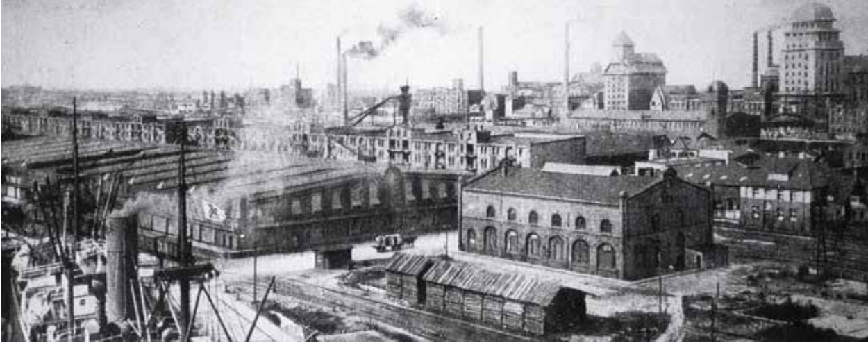
Energie-Leitzentrale und Schuppen 13 vor dem 2. Weltkrieg
