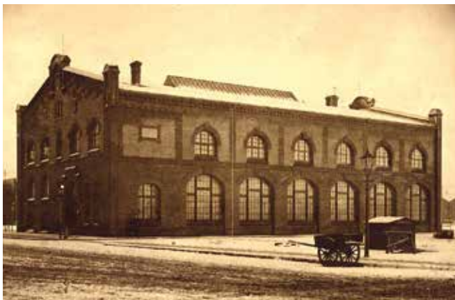
Die ehemalige Energie-Leitzentrale am Europahafen
